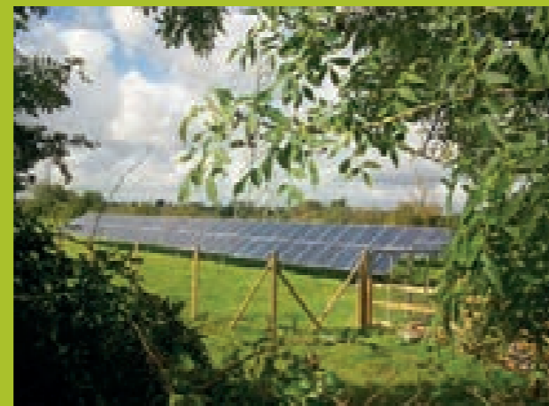
Mae paneli solar yn helpu i bweru'r pypiau i symud dŵr i ben Rhesi Lociau Caen Hill
